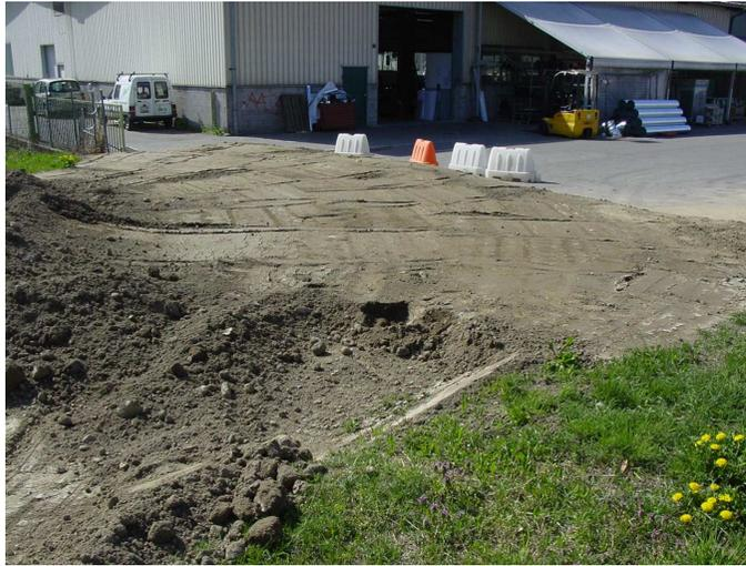
**Struttura del suolo:** posare il suolo rispettandone la struttura: orizzonte A sopra, orizzonte B sotto. (Foto: ATG Camorino, 2011).
