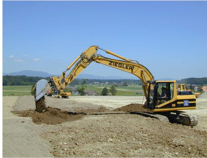
**Ripristino del suolo:** l'escavatore cingolato transita sull'orizzonte C, posando a strisce prima l'orizzonte B (sotto) e in seguito l'orizzonte A (sopra), senza mai transitare sul suolo appena ricostituito. (Foto: manuale «Gestion des terres vegetales», Canton Vaud, 2010).
