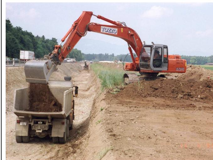
**Scarifica del suolo:** l'escavatore cingolato transita sull'orizzonte A. Gli orizzonti A e B scarificati in due tappe vengono caricati separatamente su camion che transitano sull'orizzonte C. Nessuna macchina transita sull'orizzonte B. (Foto: «Gestion des terres vegetales», Canton Vaud, 2010).
