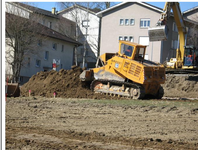
**Caricatore cingolato:** macchina non adatta per scarificare il suolo. Anche se il suo peso è uniformemente ripartito (cingolato) per agire deve percorrere più volte il suolo. (Foto: manuale «Gestion des terres vegetales», Canton Vaud, 2010).
