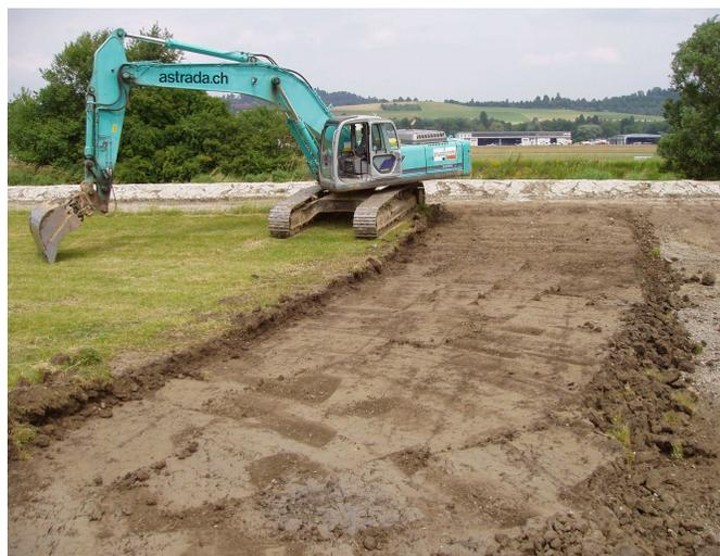
**Scarifica del suolo:** l'escavatore cingolato scarifica a strisce prima l'orizzonte A, lo carica su un camion e poi scarifica direttamente l'orizzonte B, caricandolo sul camion successivo. (Foto: «Gestion des terres vegetales», Canton Vaud, 2010).
