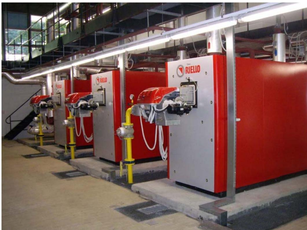
Figura 3-15: I tre generatori di calore (caldaie a gas) presso la centrale di Trevano
