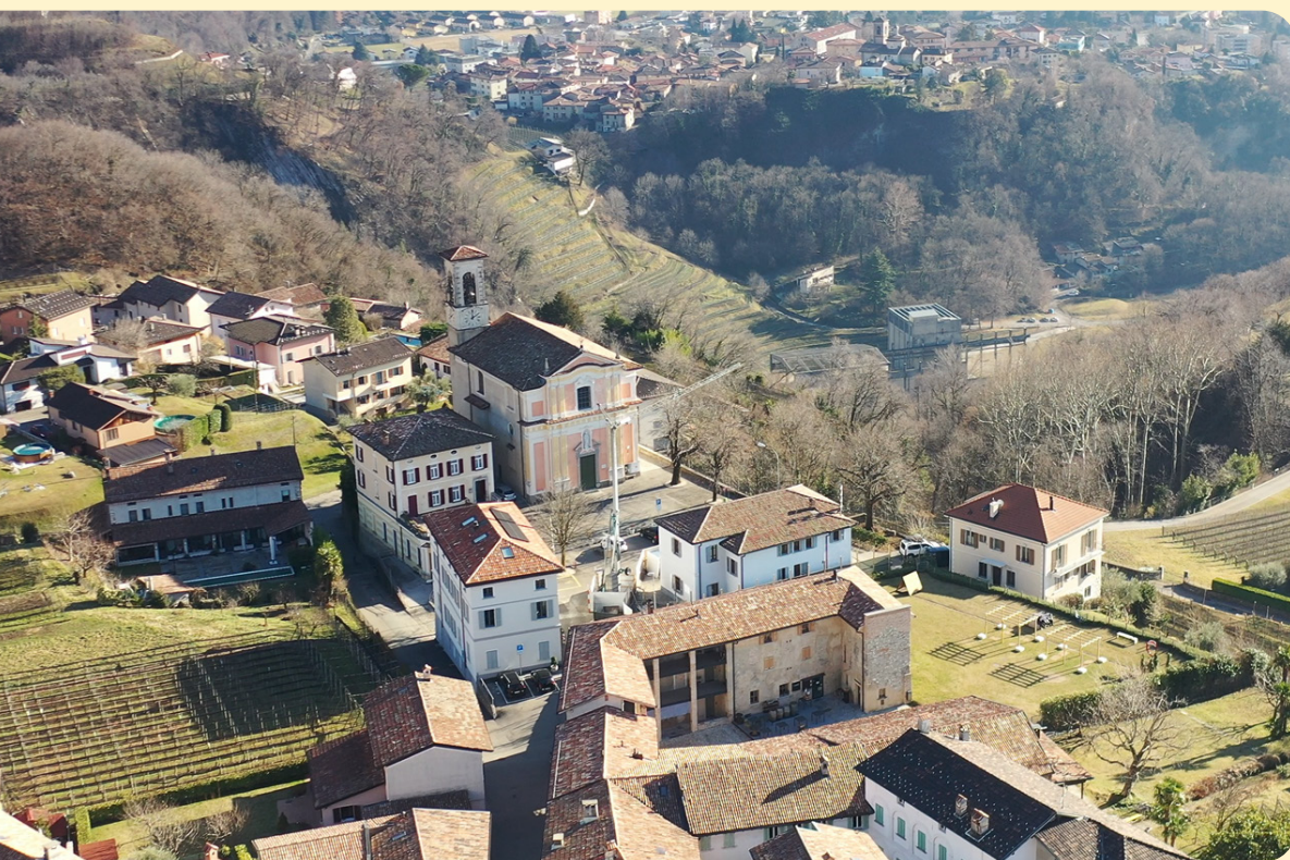
Figura 22. Stabili comunali rinnovati (stabile ex scuole ristrutturato secondo Minergie)
