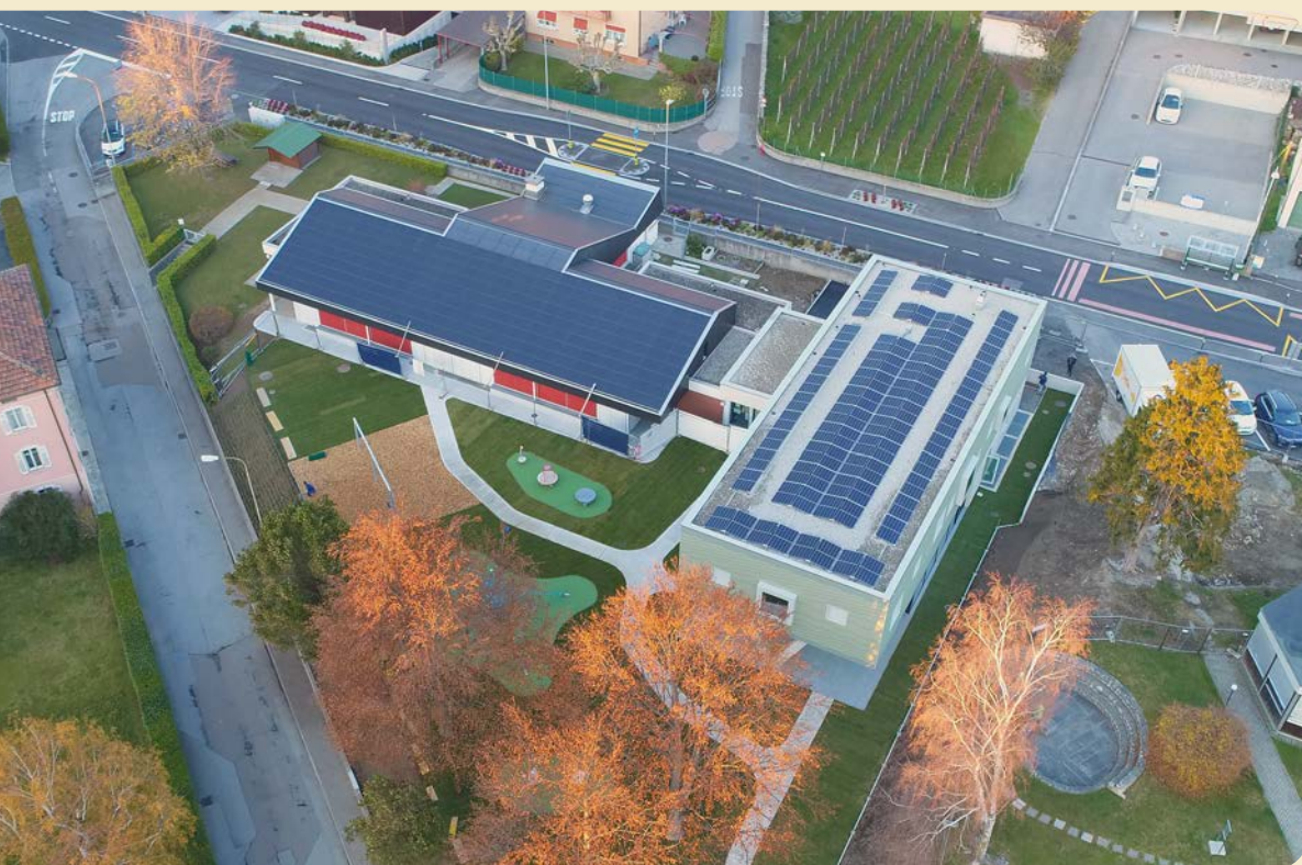
Figura 16. Stabile asilo (parte nuova) rinnovato come stabile Minergie (la parte vecchia sarà risanata durante l'estate 2023 come stabile Minergie)
