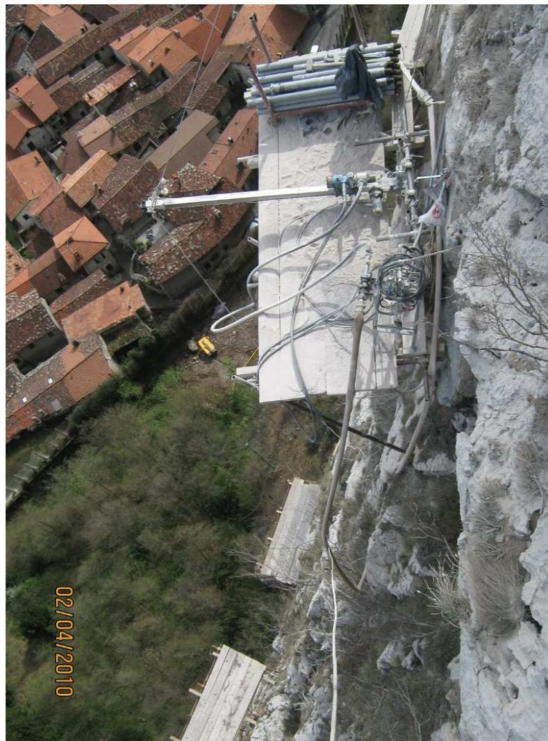
Foto 7 Area di cantiere – Piazzola attrezzata per l'esecuzione del tirante – martello fondo foro e aste di perforazione
