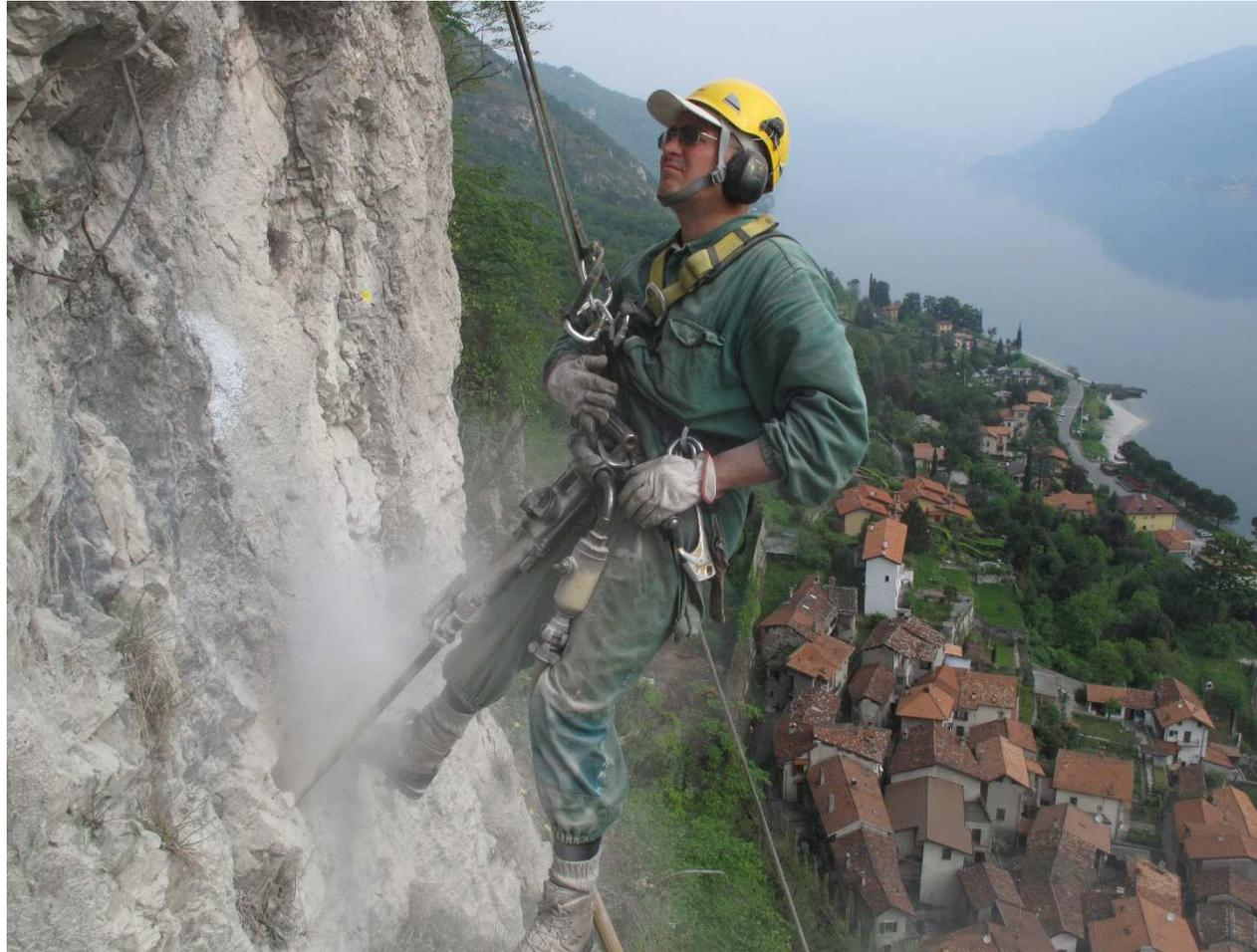
Foto 5 Area di cantiere – Perforazione manuale
