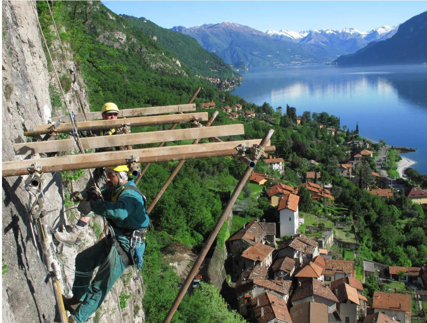
Foto 6 Area di cantiere – Preparazione piazzole per esecuzione tiranti – deposito tirante
