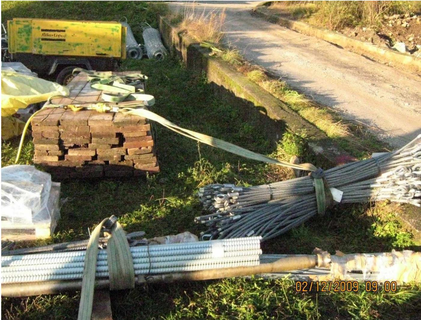
Foto 3 Area di cantiere – Area deposito con materiali pronti per il trasporto con elicottero
