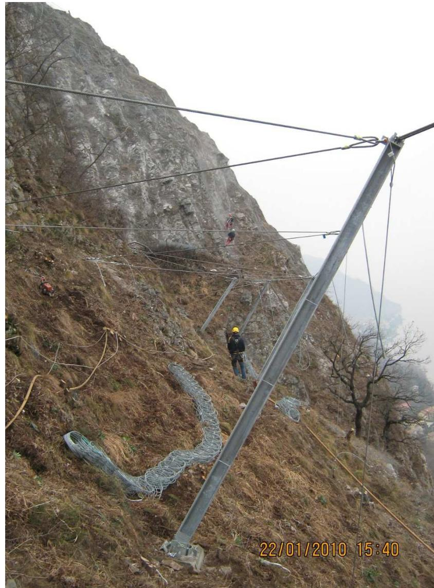
Foto 9 Area di cantiere – Barriera paramassi
