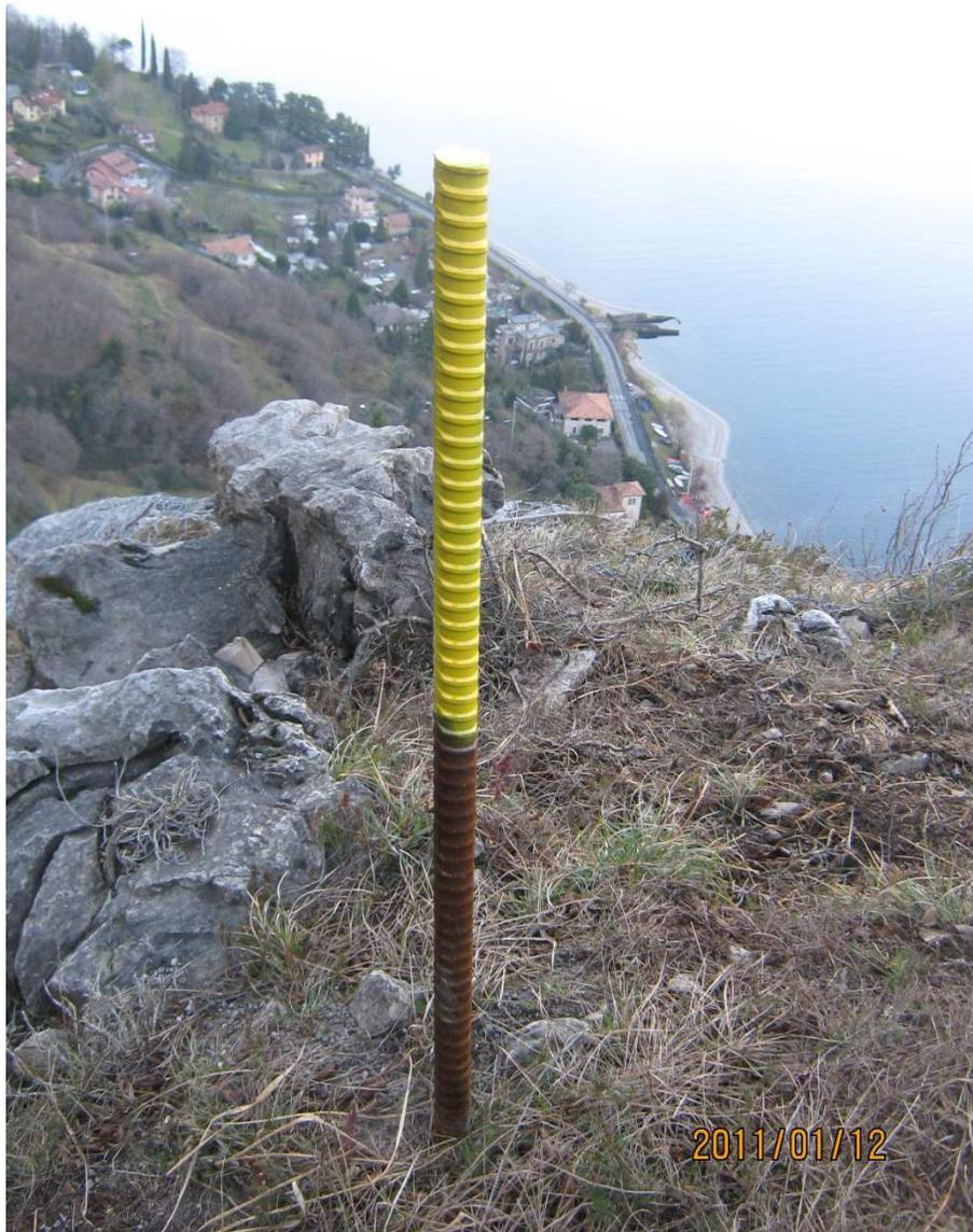
Foto 14 Punto di ancoraggio per accesso in parete per interventi di manutenzione
