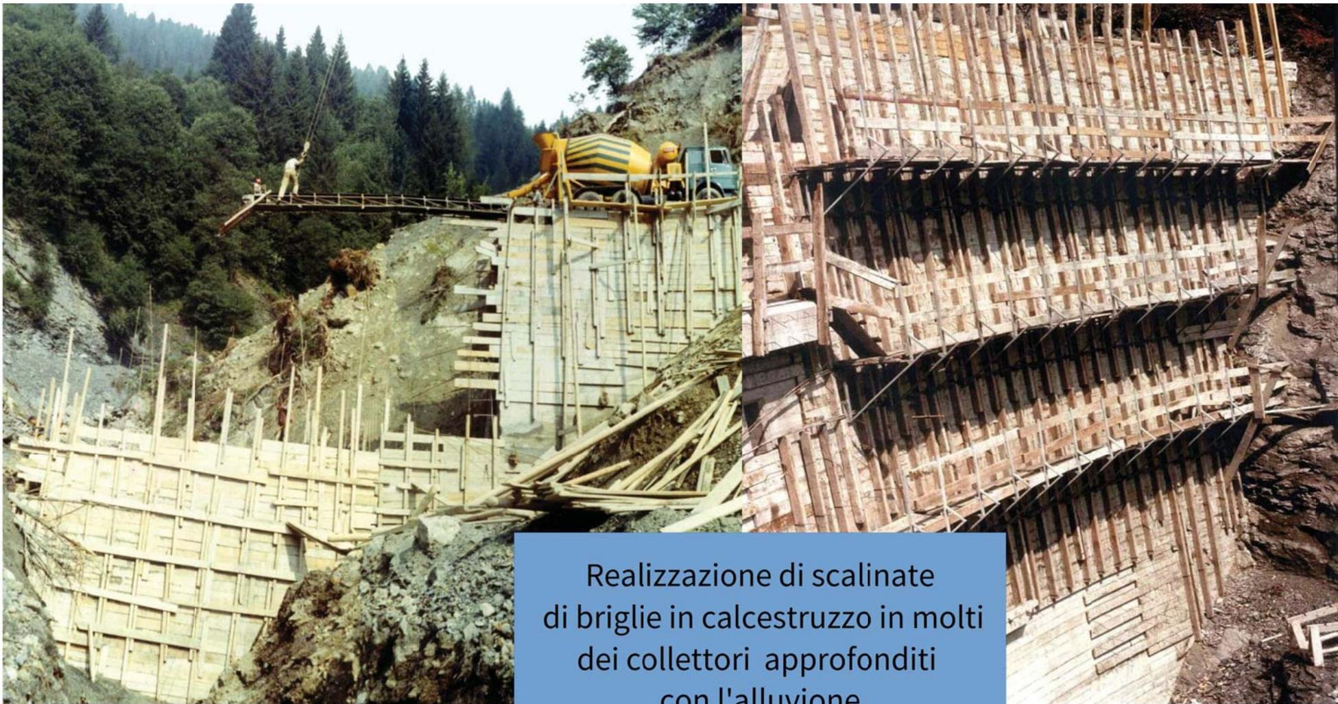
Realizzazione di scalinate di briglie in calcestruzzo in molti dei collettori approfonditi con l'alluvione
