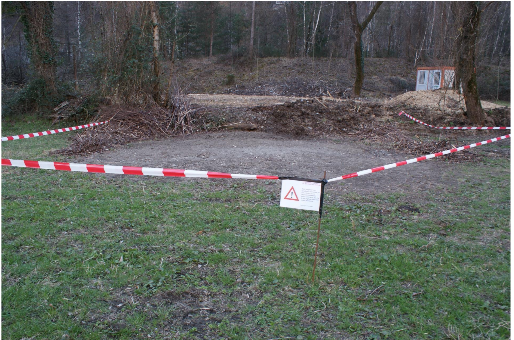
Un esempio: VM25 – dopo il primo intervento – aprile 2020
