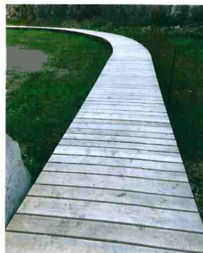
Figura 3: passerella in legno di robinia alle Cave di Arzo (Foto: Eco2000 SA)
