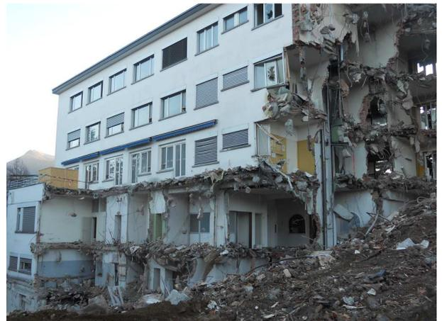
Figura 1 – Esempio di lavori di demolizione sospesi in ragione del mancato accertamento preliminare sulla presenza di sostanze pericolose a tutela dei lavoratori (cantiere del 2011 nel luganese).
