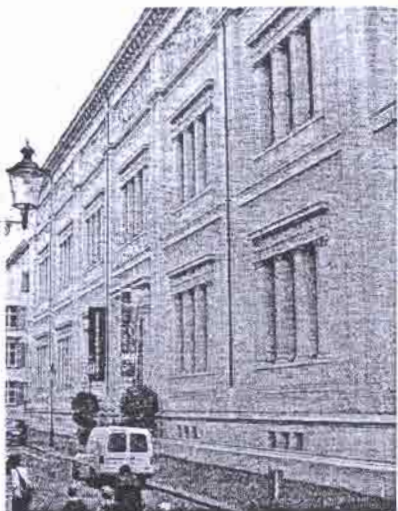
Naturhistorisches Museum Basel Noch nicht saniert, die nötigen Arbeiten werden in den nächsten Monaten erfolgen.
