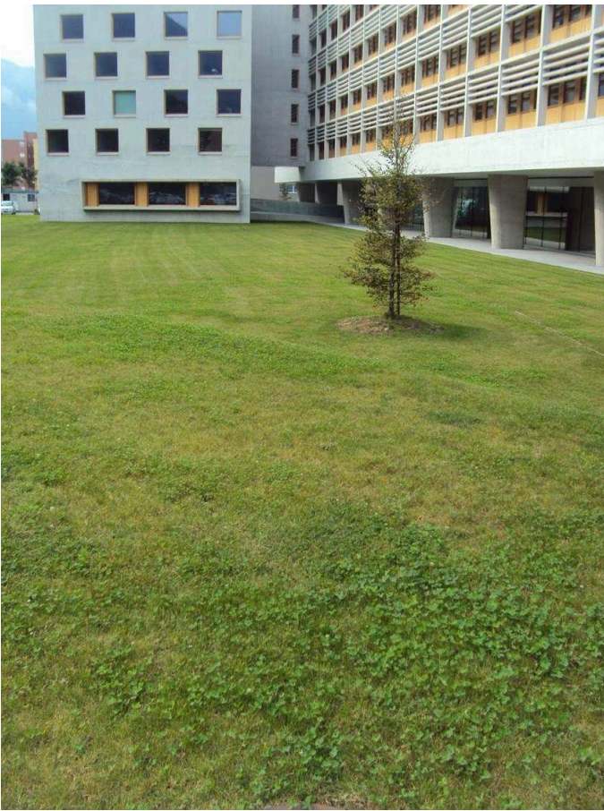
Stabile amministrativo 3, lato Sud.
