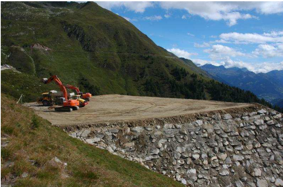
Le fasi finali della costruzione del terrapieno delle Traverso di Cavanna.
