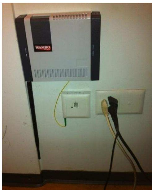
Figura 3: distributore di fibre in un condominio (BEP) e modem (Internet, Wifi, telefono e TV HD) presso il cliente
