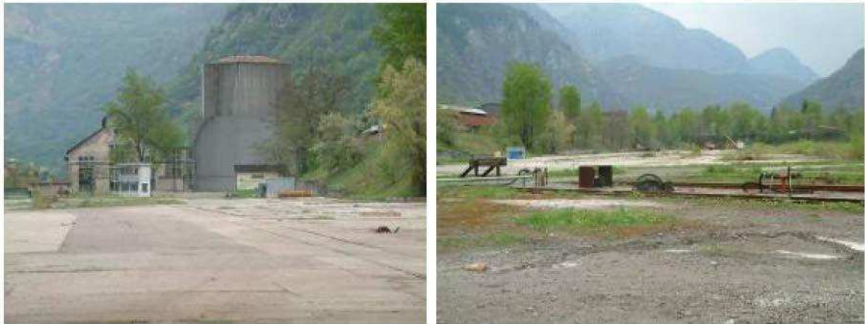
Figura 2 - Stato attuale dei siti di ubicazione dell'AM e CCVP. Fonte: USTRA
