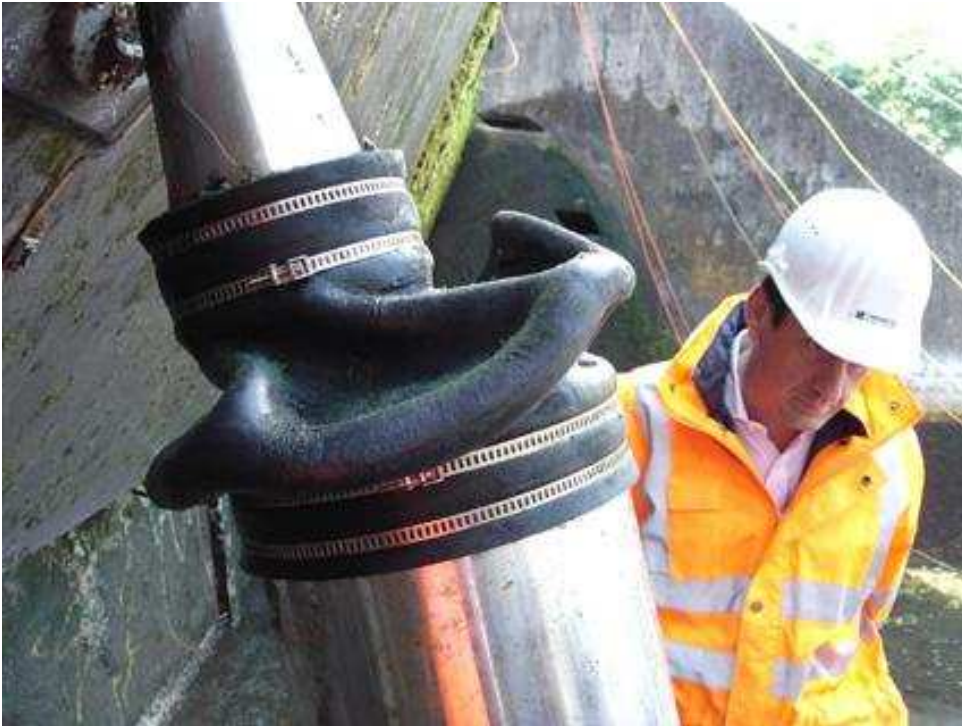
Foto 7: Membrana di tenuta nel giunto tra pistone e asta oscillante
