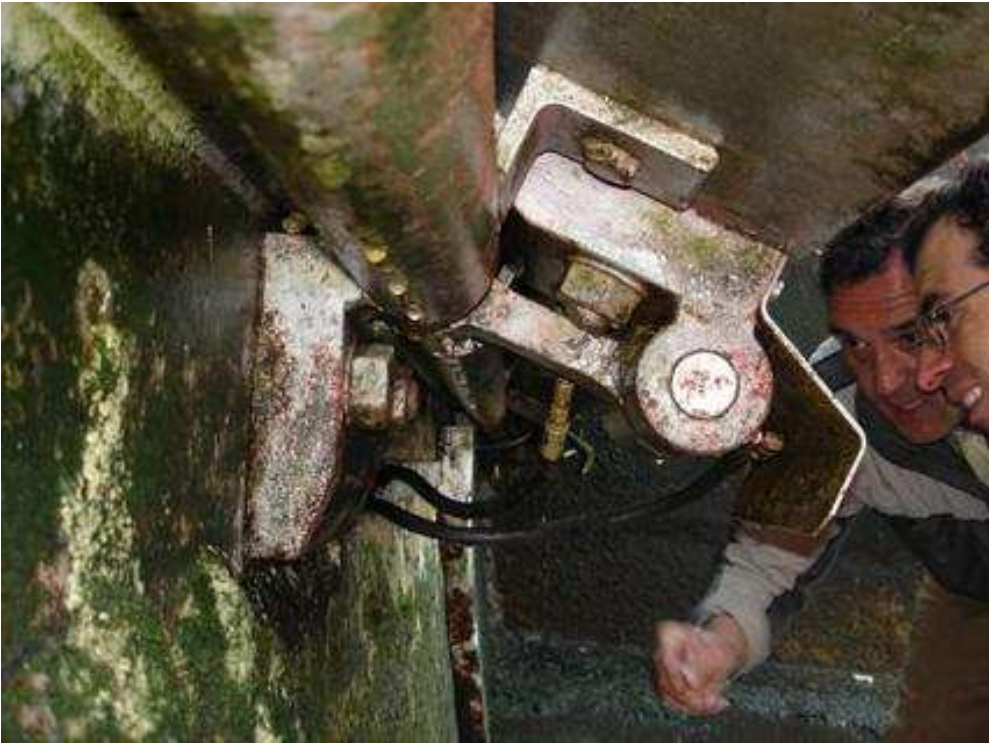
Foto 9: Particolare di una cerniera della paratoia a ventola
