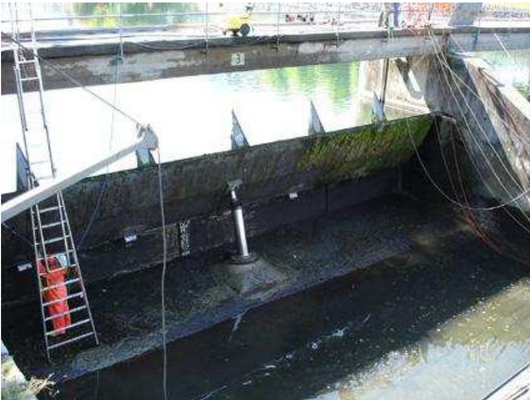
Foto 3: Vista da valle della paratoia a ventola n. 3
