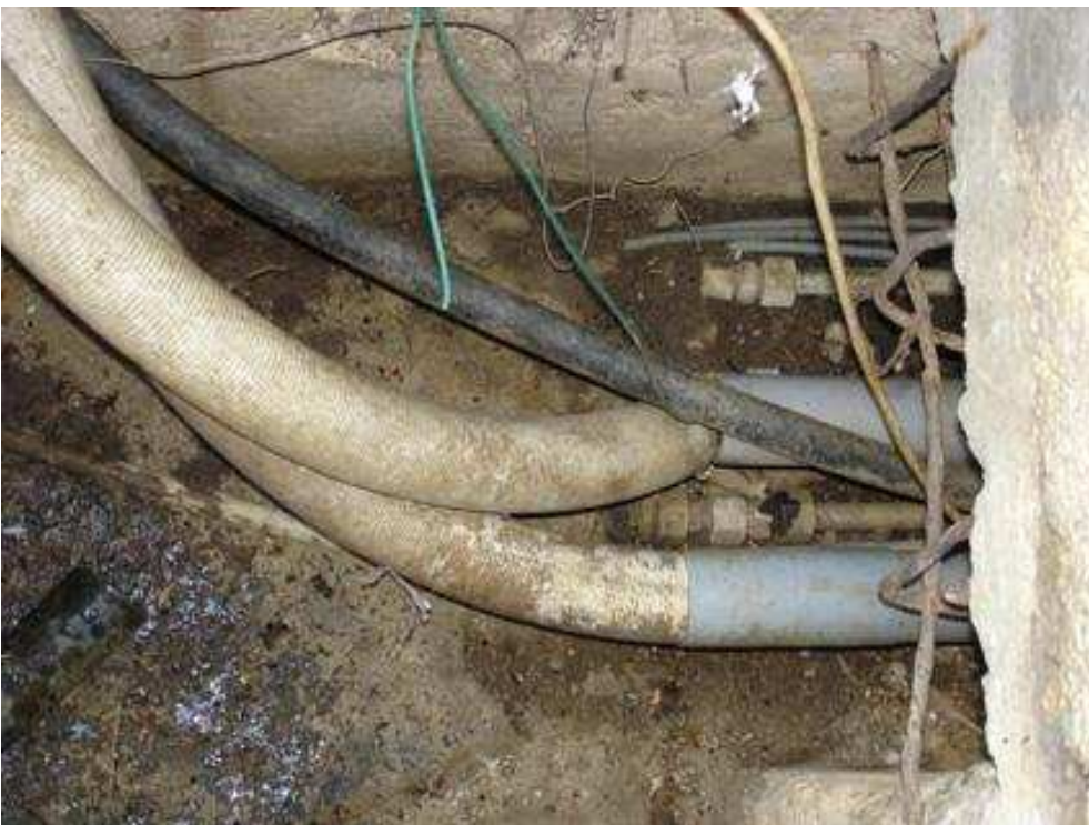
Foto 14: Pozzetto di ispezione
