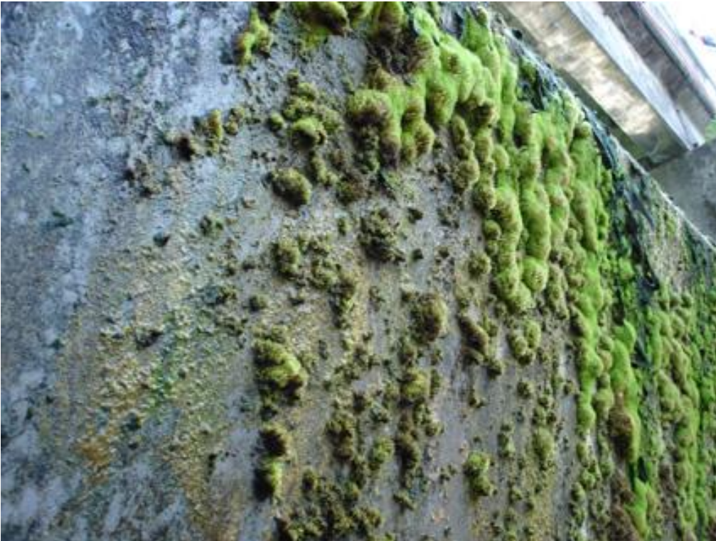
Foto 13: Condizioni di incrostazione della ventola lato valle
