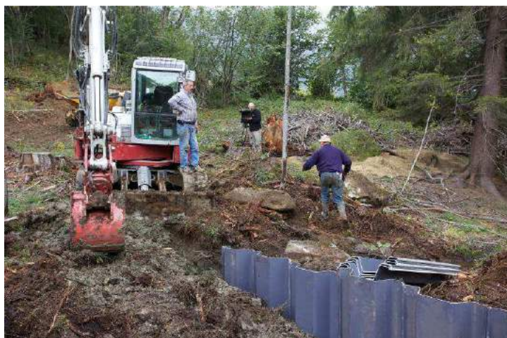
Figura 68: posa delle palancole
