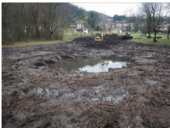
Figura 1: la superficie durante i lavori
