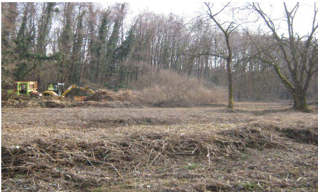
Figura 78: durante i lavori
