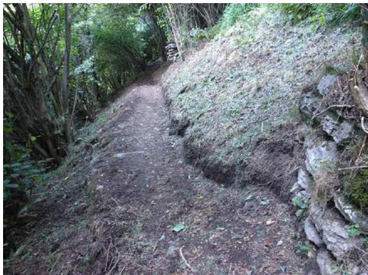
Figura 26: sistemazione del sentiero di accesso
