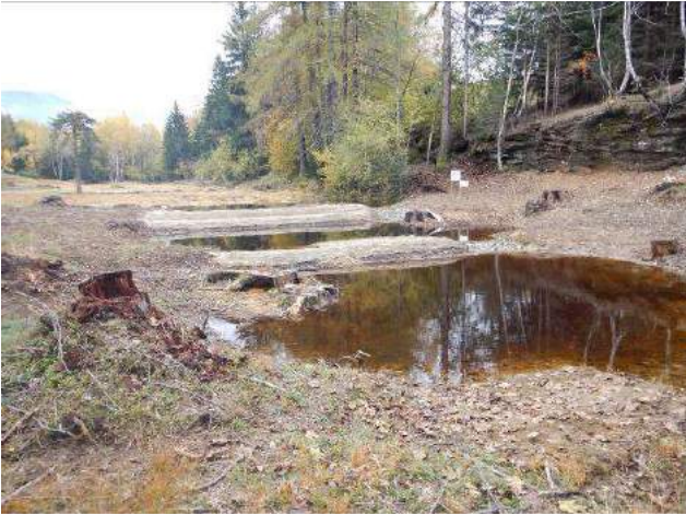
Figura 69: situazione barriere a lavori ultimati
