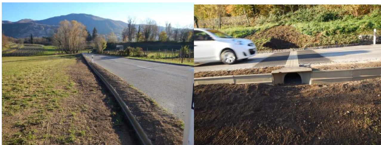
Figure 94 e 95: dettaglio barriere (sinistra) e sottopasso anfibi (destra).
