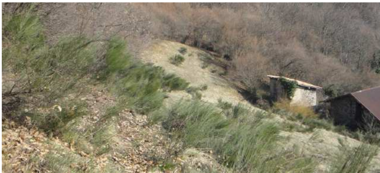
Figura 11: superficie prima degli interventi
