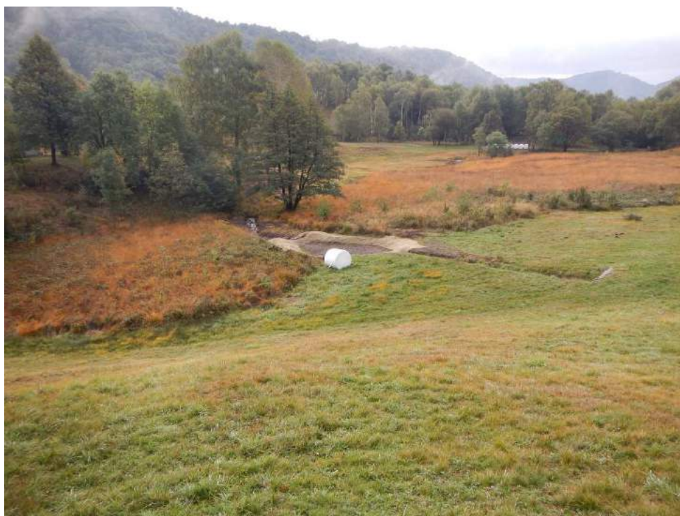
Figura 61: intervento presso il riale Fontanella
