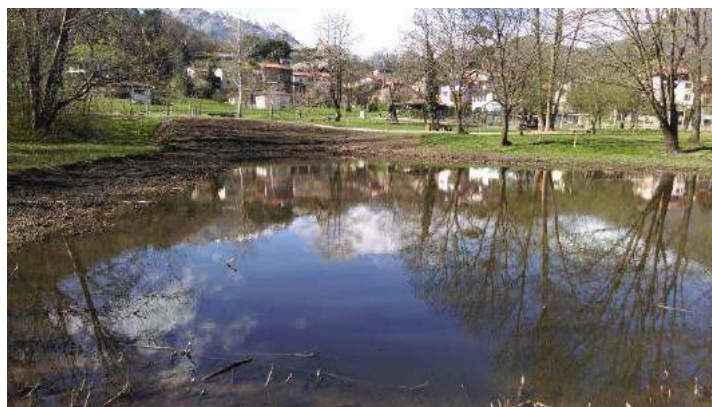
Figura 2: cantiere appena ultimato
