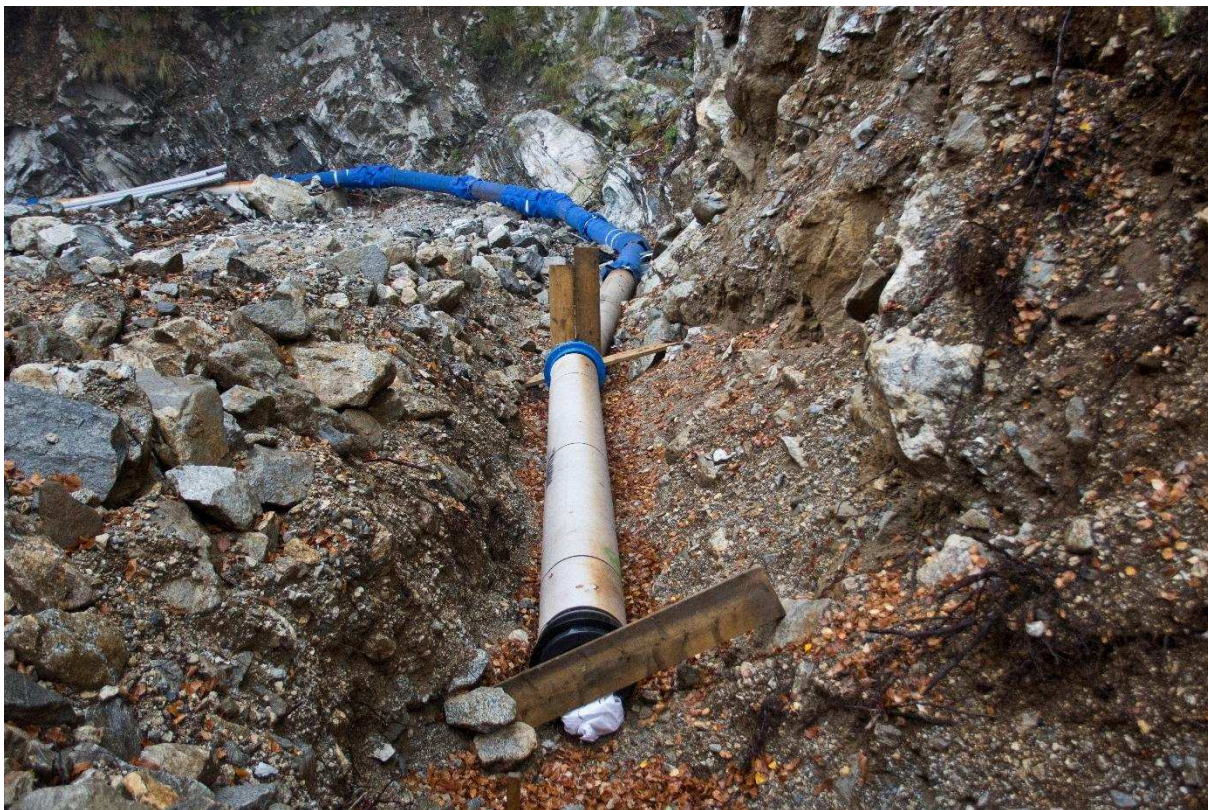
Foto 3. Scavi in roccia per la posa condotta. © Raphael Weber / Pro Natura
