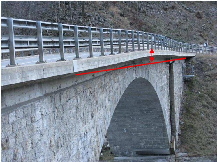
Fig. 3: Innalzamento della parte centrale dell'arco (chiave)
