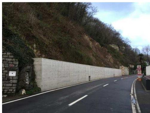
Foto 2: Brusino, rimozione del materiale e nuovo muro di contenimento
