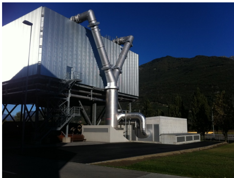
Stazione di pompaggio
