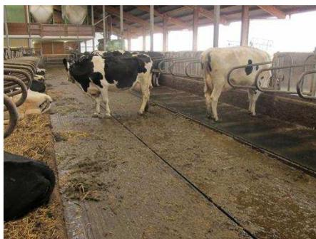
Per raggiungere lo scopo sopraccitato è necessario realizzare i corridoi di camminamento, nelle stalle, con un pavimento non forato ed un'inclinazione trasversale del 3% con nel mezzo un canale di raccolta delle urine e con un dispositivo mobile di evacuazione.
