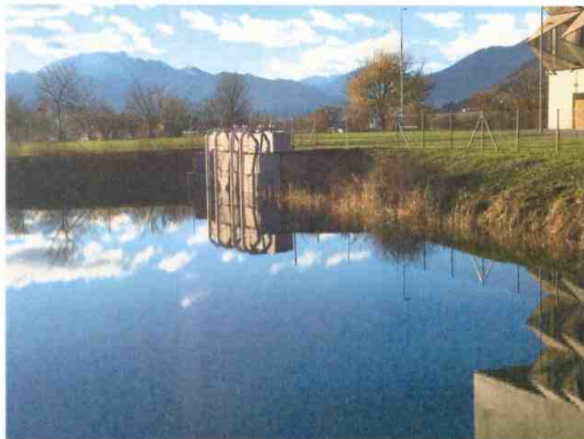
Presa d'acqua per i pompieri
