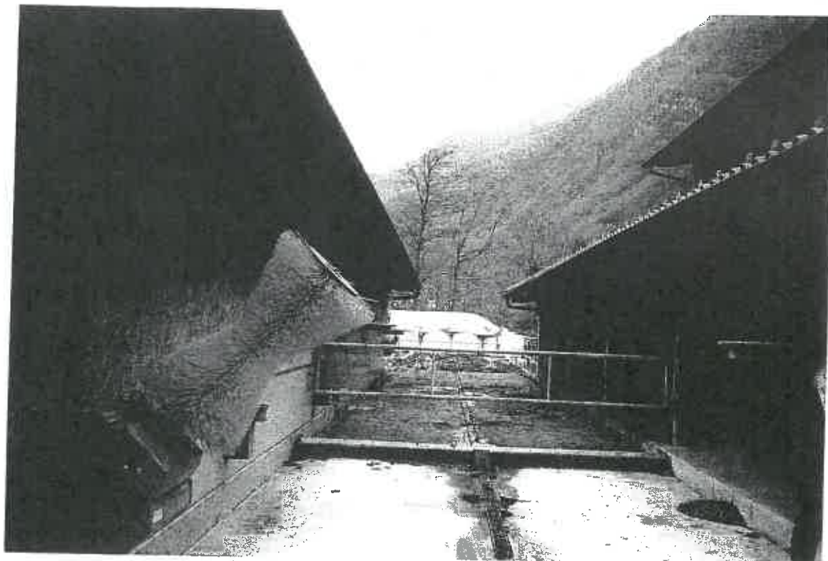
Il piazzale collega la stalla alla mangiatoia e fienile e dà accesso ai pascoli. Aperto e pavimentato, è dotato da un raschiatore meccanico; il letame separata dal liquame cade nel letamaio
