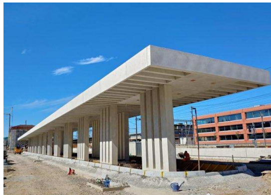
Fotografie dei lavori – stato agosto 2020
