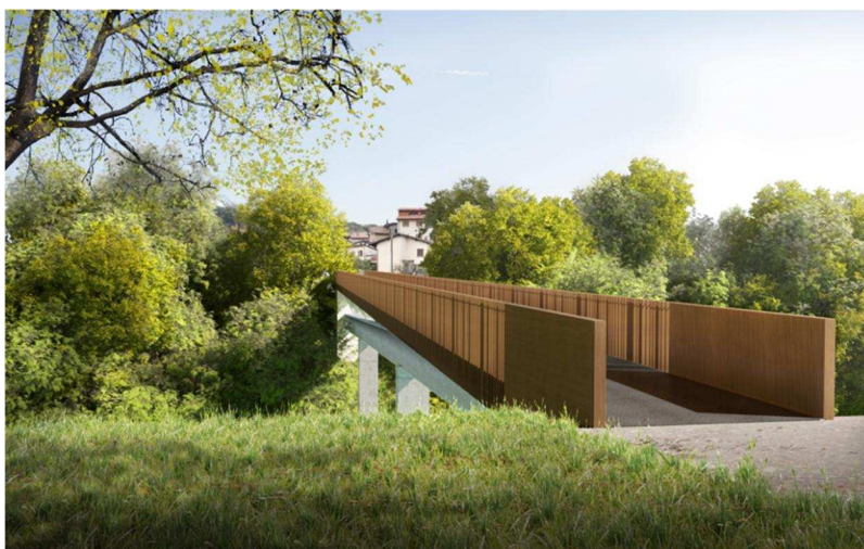
Vista verso Lugaggia
