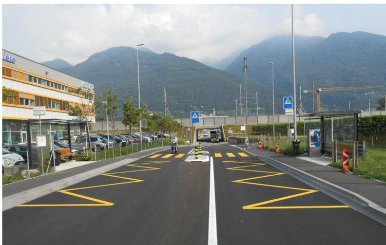
Solo quando non è possibile la realizzazione del bordo speciale, in particolare se la geometria stradale non lo permette, si può ricorrere quale soluzione di ripiego a un marciapiede con bordo da 16 cm che consente l'impiego di una rampa mobile. In questo caso la rampa mobile deve essere messa in posizione da parte del personale di servizio (autista).
