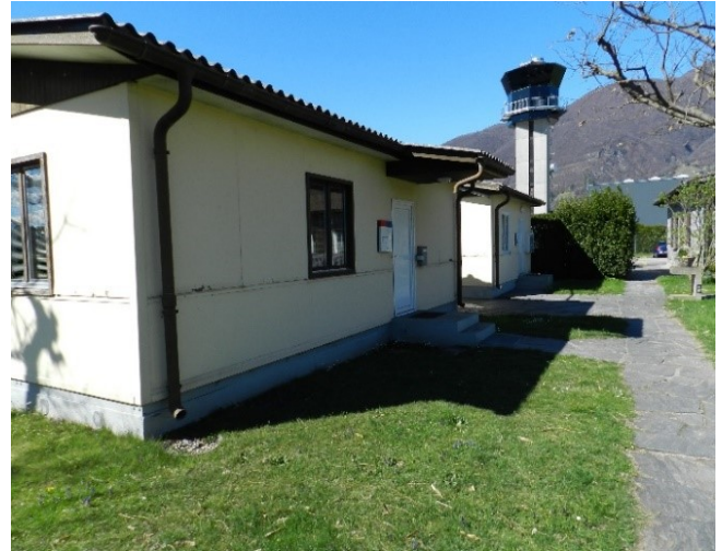
Attuale sede della Direzione dell'aeroporto
