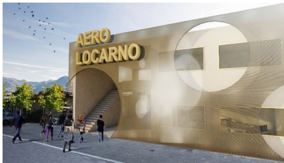
Immagine facciata nuovo hangar 1.
