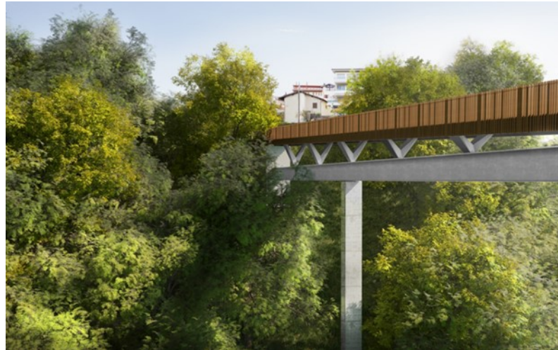
Vista generale della struttura esistente con i nuovi cavalletti e la nuova piattabanda
