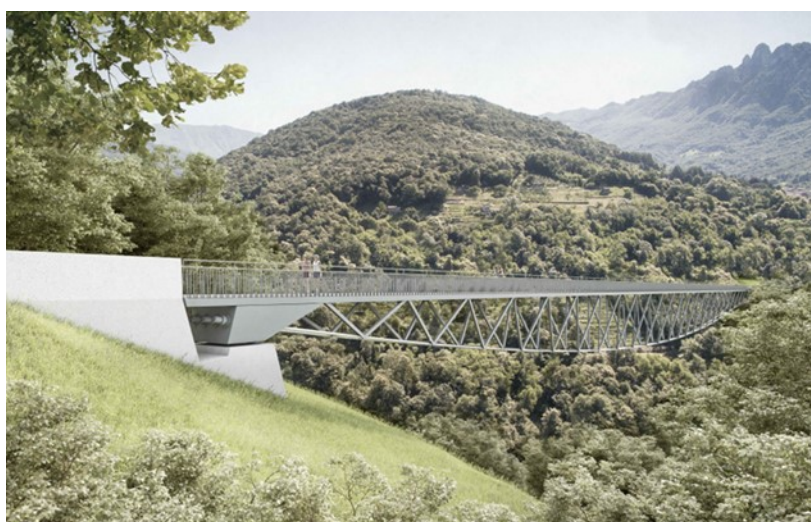
Visualizzazione Ponte Spada
