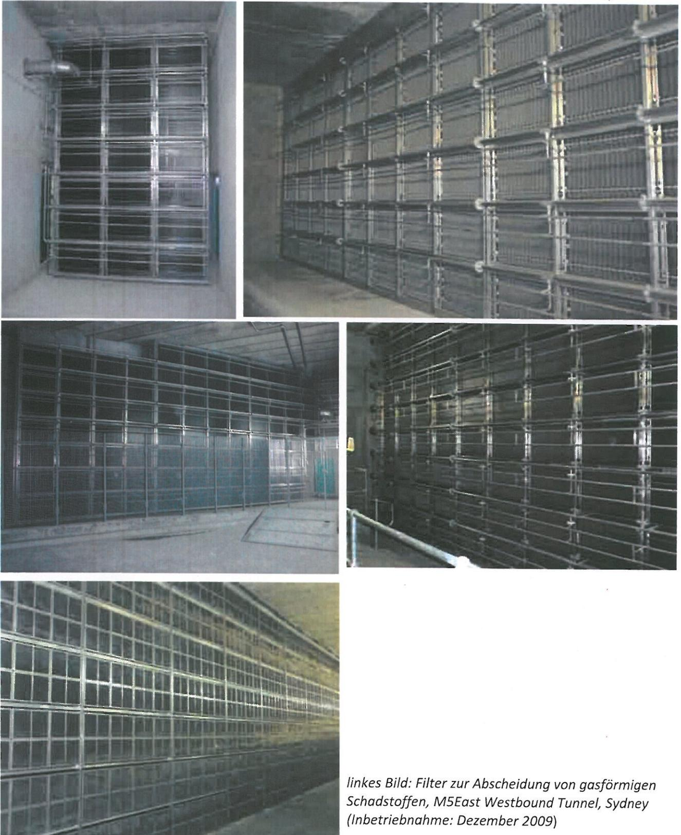
*linkes Bild: Filter zur Abscheidung von gasförmigen Schadstoffen, M5East Westbound Tunnel, Sydney (Inbetriebnahme: Dezember 2009)*
